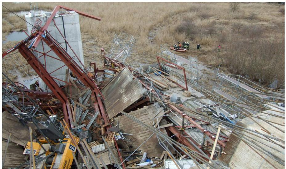
Abb. 7 Versagen der Baggerfahrbahn mit deformierten Hilfsstützen
