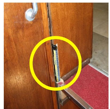
Abb. 10 Sicherheitsfunktion mittels Lichtgitter im Fußbereich an allen Schachtzugängen
