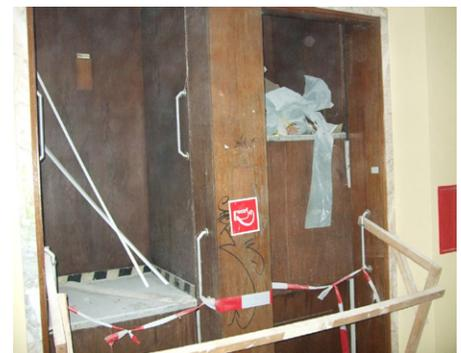
Abb. 3 Zustand der Schachtzugänge und der Sicherungsmaßnahmen vor der Ertüchtigung im Oktober 2009
