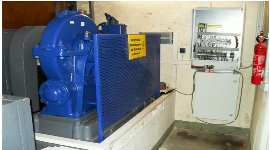
Abb. 11 Triebwerksraum, Maschine und Teile der Steuerung nach der Ertüchtigung im Juni 2010
