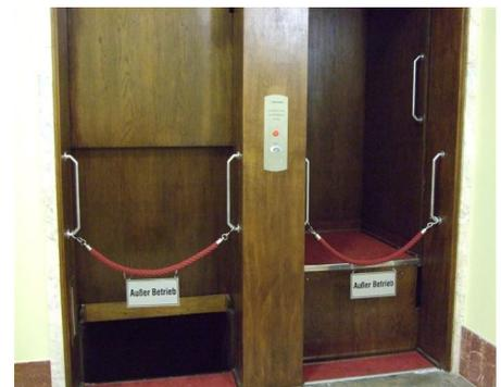
Abb. 4 Zustand des Schachtzugangs nach der Ertüchtigung im Juni 2010, bei kurzfristiger Stillsetzung mit Hanfseile gesichert
