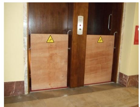
Abb. 5 Schachtzugänge bei längerfristiger Stillsetzung mit fester Umwahrung gesichert
