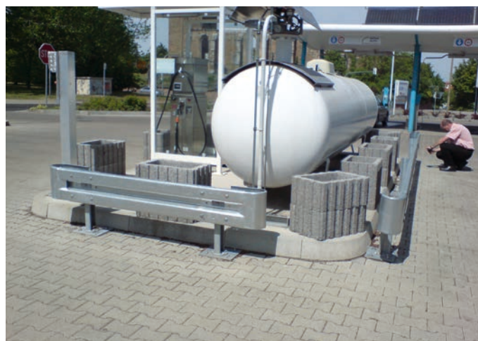
Abb. 3 mangelhafter Anfahrerschutz mit Betonblumenkübel und Leitplanke
