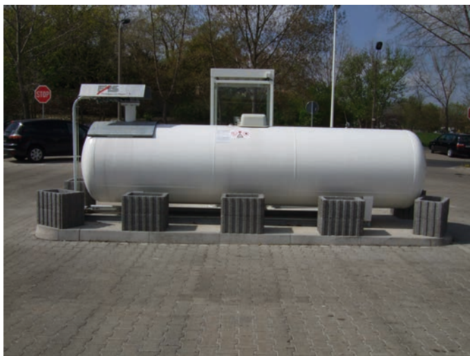
Abb. 2 Betonblumenkübel als Anfahrerschutz
