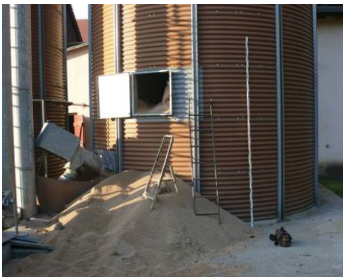
Abb. 1 untere Revisionsöffnung des Stahlrundsilos
